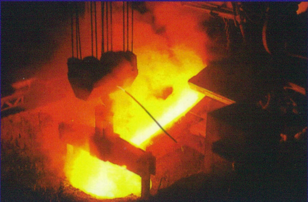
Electric Arc Furnace เตาหลอมเหล็ก
